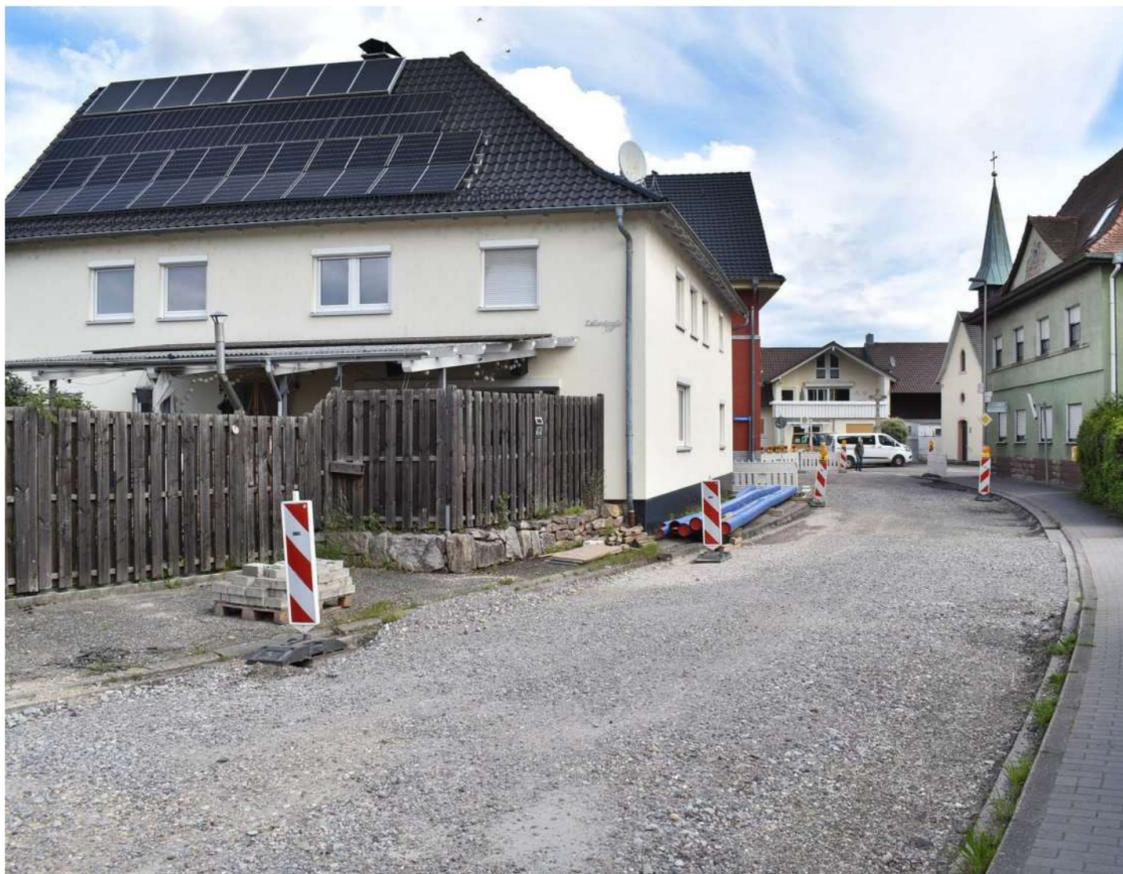
Die Dorfheizung Unzhurst wird nach Zell ausgedehnt. Die Wärmeleitungen werden bei der laufenden Sanierung der Ortsdurchfahrt mit verlegt. Foto: Joachim Eiermann
